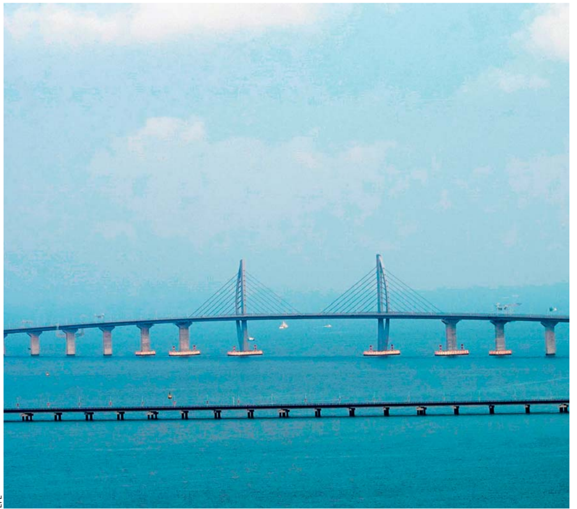
EL MAYOR VIADUCTO DEL MUNDO EN MAR ABIERTO Y UNA DE LAS OBRAS FARAÓNICAS DE CHINA.
