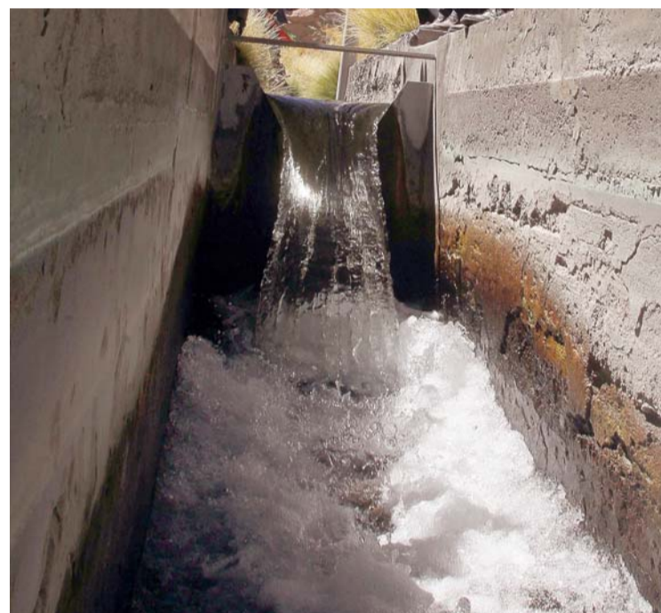
EFE CHILE RECIBE 180 LITROS POR SEGUNDO A TRAVÉS DE CANALIZACIONES ARTIFICIALES QUE FUERON CONSTRUIDAS PARA DESVIAR LOS RECURSOS HÍDRICOS BOLIVIANOS, PERO NO PAGA NI UN CENTAVO.
