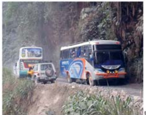
EN LA VÍA COTAPATA - SANTA BÁRBARA, EN EL SECTOR DE CHORO BAJO, HAY 2 DEFRUMBES, EN UINDUJÍ - CHULUMANI, EN EL SECTOR DE YERIBANI, HAY DESLIZAMIENTOS.
