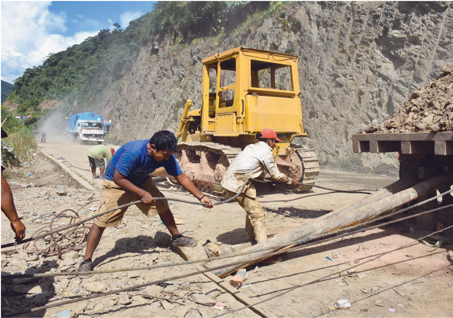
TRABAJO DE ESTABILIZACIÓN EN EL SECTOR DE PUENTE ARMAS, EN EL TRAMO SANTA BÁRBARA - CARANAUI, RUTA QUE FUE AFECTADA POR EL DESLIZAMIENTO.
