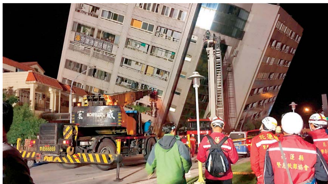
EDIFICIO DE HUALIEN A PUNTO DE COLAPSAR DESPUÉS DEL MOVIMIENTO TELÚRICO EN TAIWÁN.
