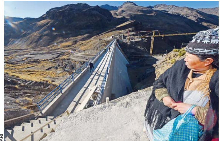
COMUNARIA DE HAMPATURI OBSERVA LA OBRA ENTREGADA AYER.
