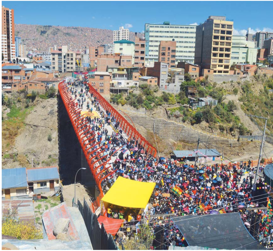
PUENTE "SAN ANTONIO DE PADUA".
