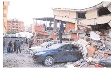
SÓLO EN ERGIS, AL MENOS 55 EDIFICIOS HAN QUEDADO TOTALMENTE DESTRUIDOS.
