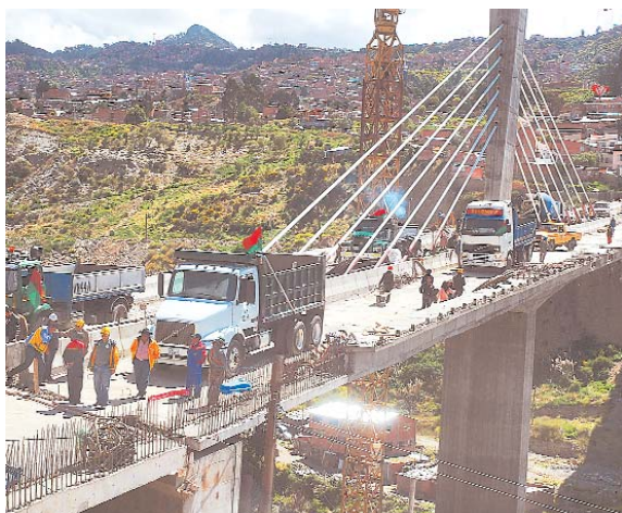
UNO DE LOS Puentes TRILLIZOS SOBRE EL ORKOJAHUIRA ES SOMETIDO A UNA PRUEBA DE RESISTENCIA DE MÁS DE 50 TONELADAS DE PESO, EQUIVALENTE A 30 VEHÍCULOS.
