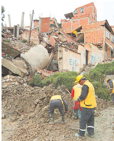
RESQUEBRAJAMIENTO DE TIERRA OCASIONA DESLIZAMIENTO DE CASAS EN RETAMANI I.
