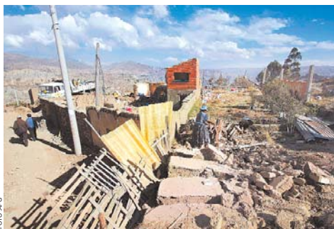
MÁS VIVIENDAS ESTÁN EN RIESGO DE DESPLOMARSE DEBIDO AL FENÓMENO GEOFÍSICO QUE SE REGISTRÓ EN VILLA SALOMÉ EL PASADO VIERNES.
