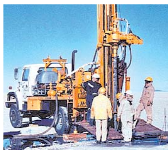
CONTINUAN EJECUTANDO TRABAJOS DE PERFORACIONES EN EL SALAR DE UYUNI.
